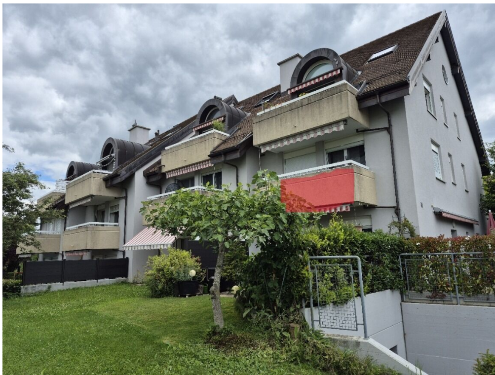
Vue balcon sud
